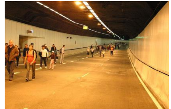
Sydney Harbour Tunnel (AUS)
