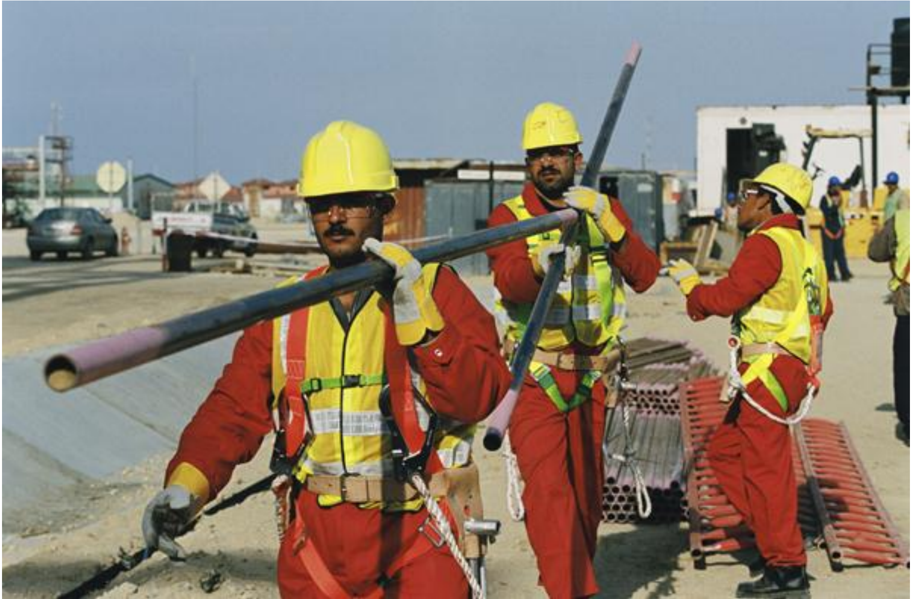
BG LNG Plant, Idku, Egypt
